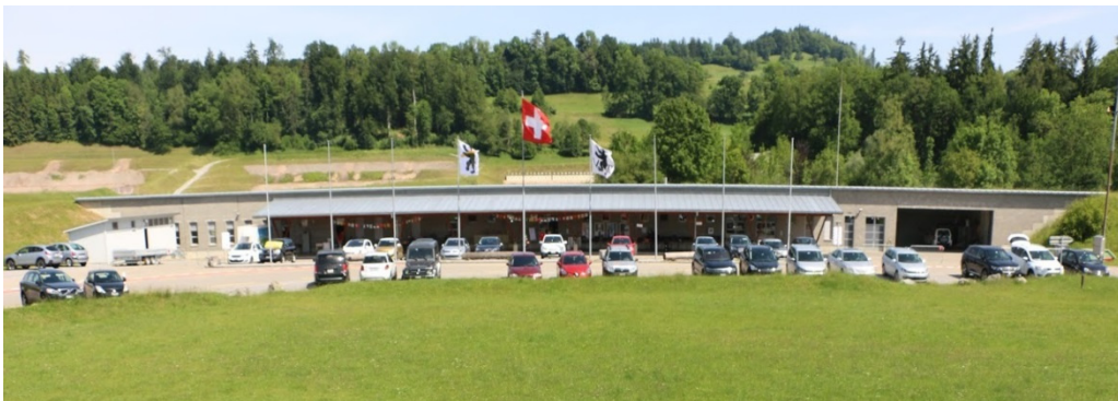
300m Schiessanlage «Gossau Breitfeld»
